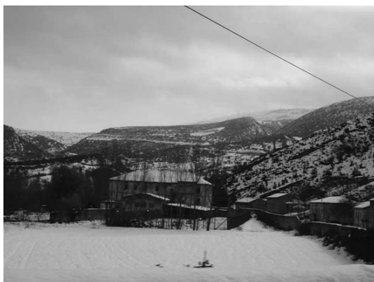
Figura 1.- Imagen del edificio del penal en marzo del 2007.
